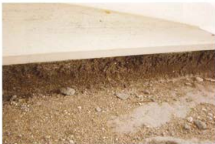
採用大型磁磚鋪貼地坪施工法的拋光石英磚地坪
