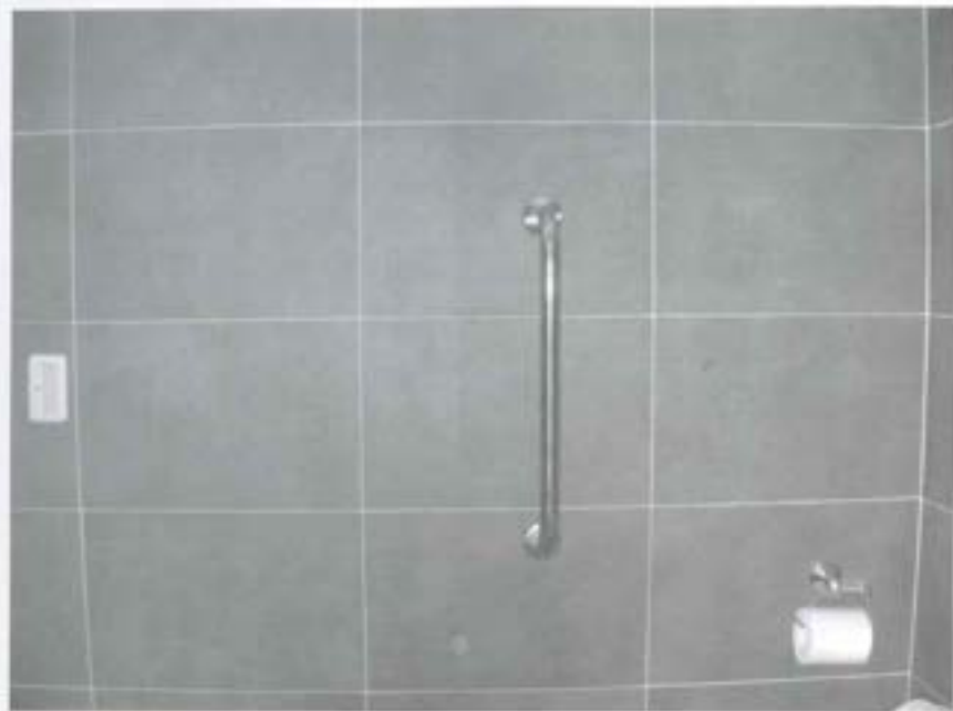
依上述方法施工完成的大型磁磚牆面
