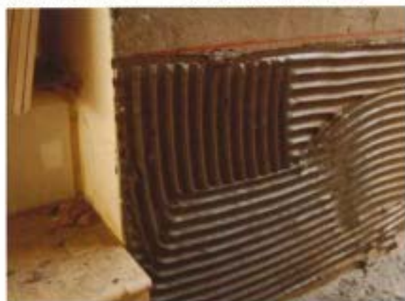
在打底及放樣完成的牆面塗抹鋪貼磁磚用的水泥砂漿
