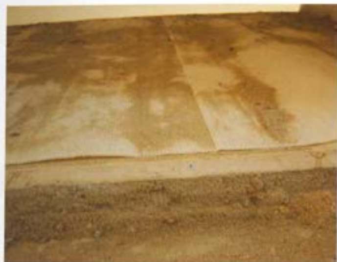
以適當的材質保護之完工後地坪
