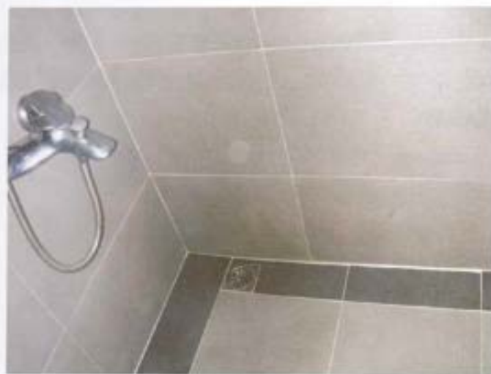
採用大型磁磚的地坪置於牆邊的平頭落水頭
